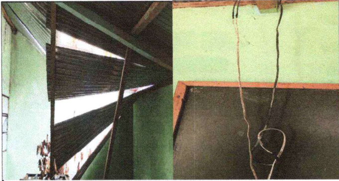
Foto1: Rehabilitación de estructura de soporte de madera a costanera y lamina troquelada. Sustitución de ducto eléctrico más accesorios.
