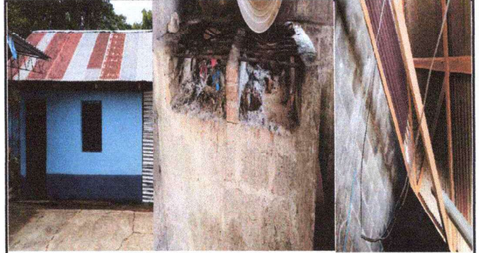
Foto 2: Sustitución de soporte de madera a costanera y lamina acanalada a troquelada. Sustitución de estufa rural (completa) incluye chimenea y plancha de metal. Sustitución de ducto eléctrico mas accesorios.
